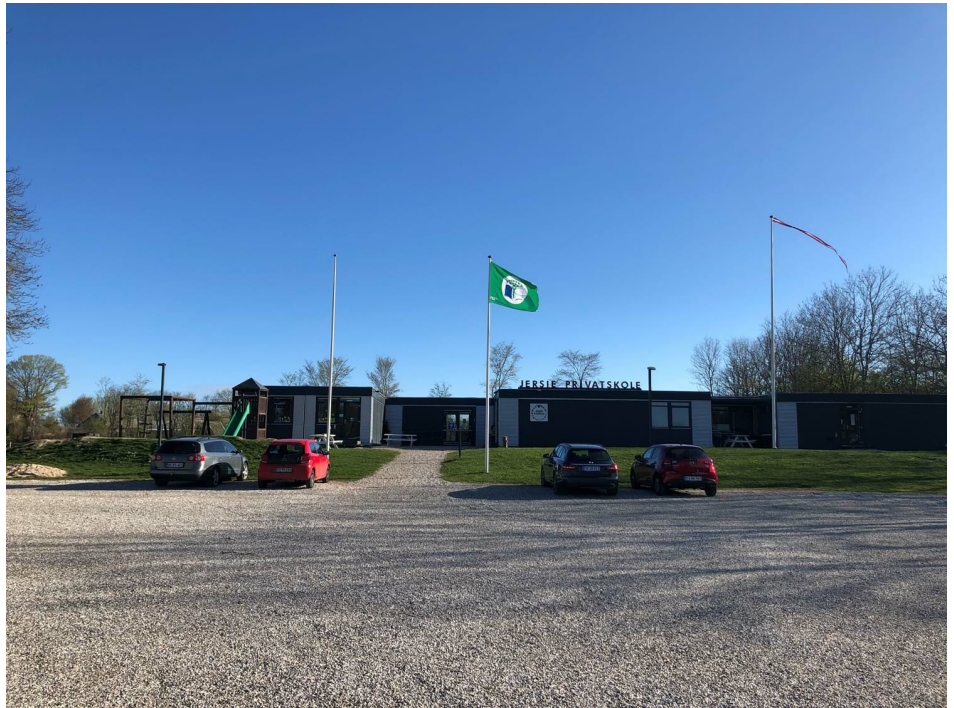
Billede 1 - Skolens midlertidige bygninger.
