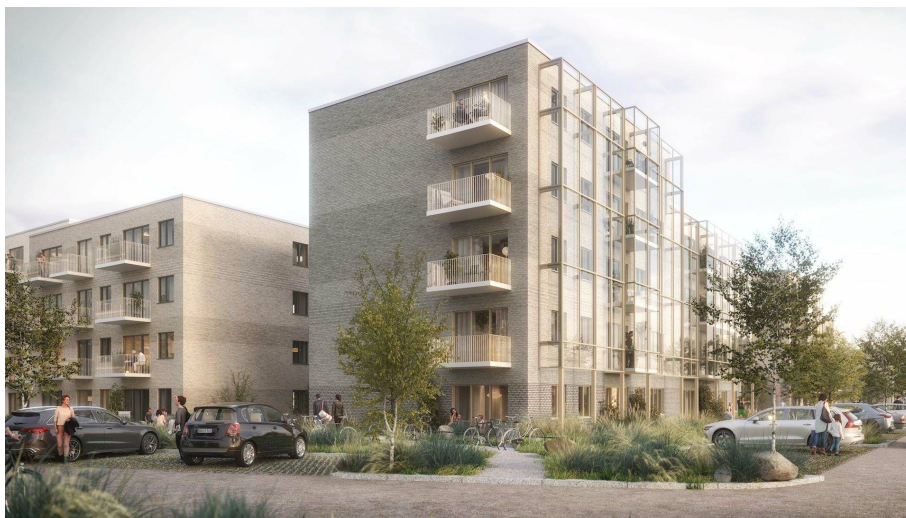
Figur 8 - Bebyggelsen set fra sydvest. Ved den ene facade ses afskærmende foranstaltninger i form af glasskærm.
