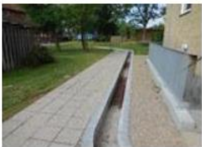
Figur 9 Eksempel på afløbsrende
