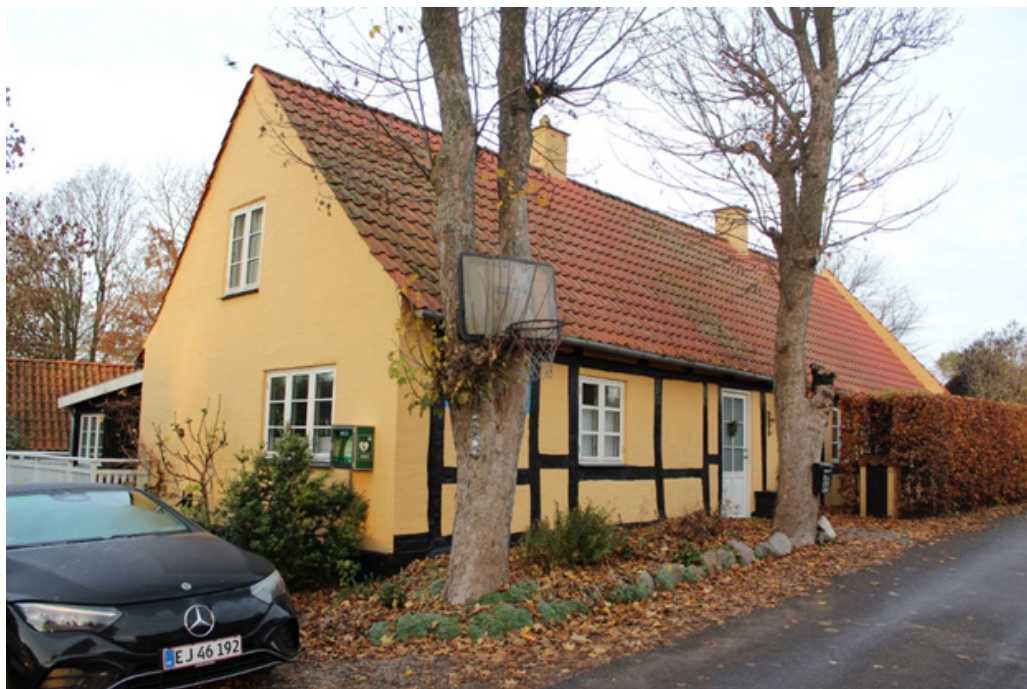
Foto: Sydøstvendt gadefacade set fra Kalkværksvej
