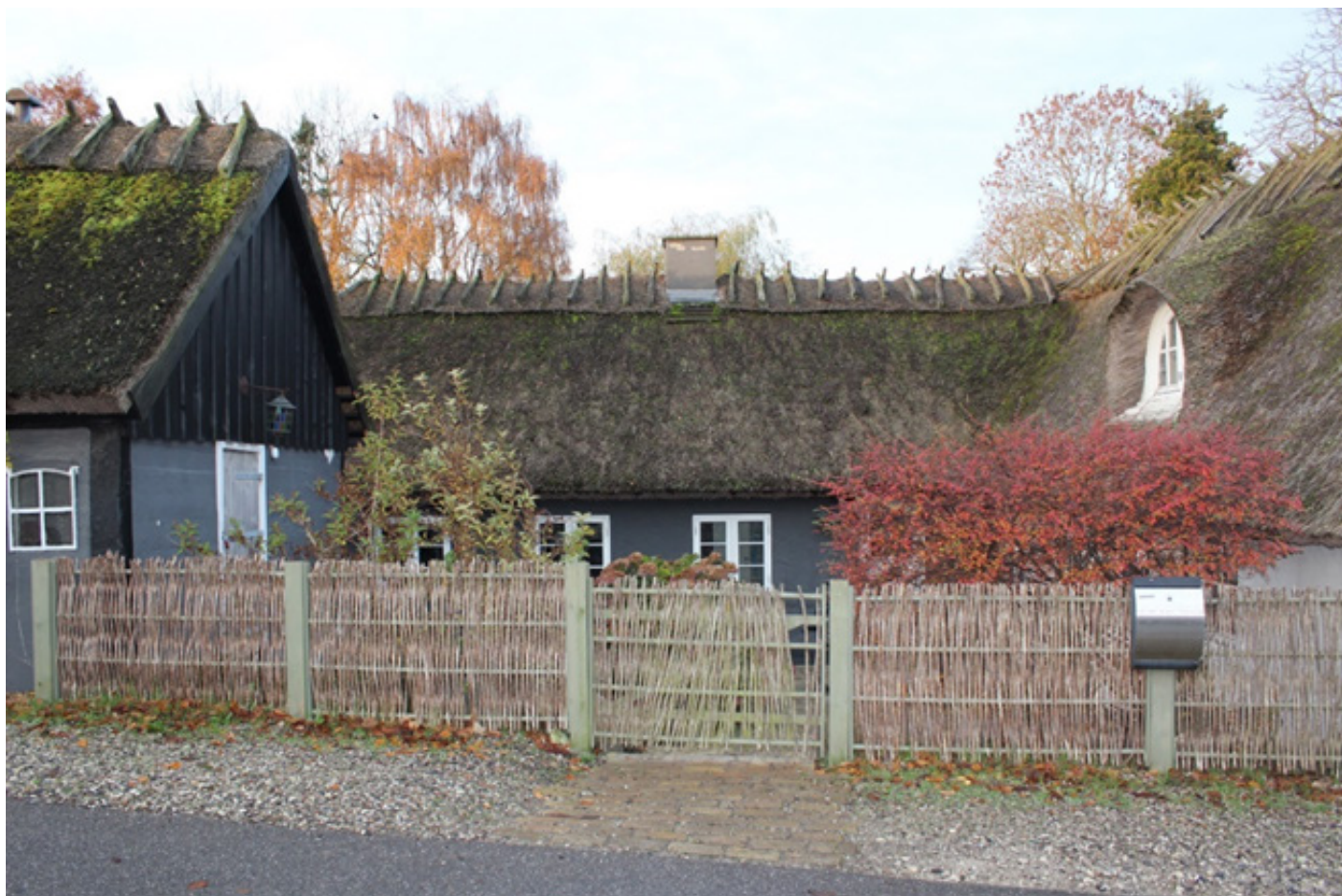
Foto: Garagebygning, sidebygning og længehus set fra Kalkværksvej.
