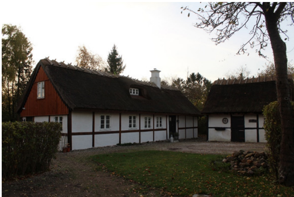
Foto: Længehus og udhus set fra nordvest og fra Strædet.
