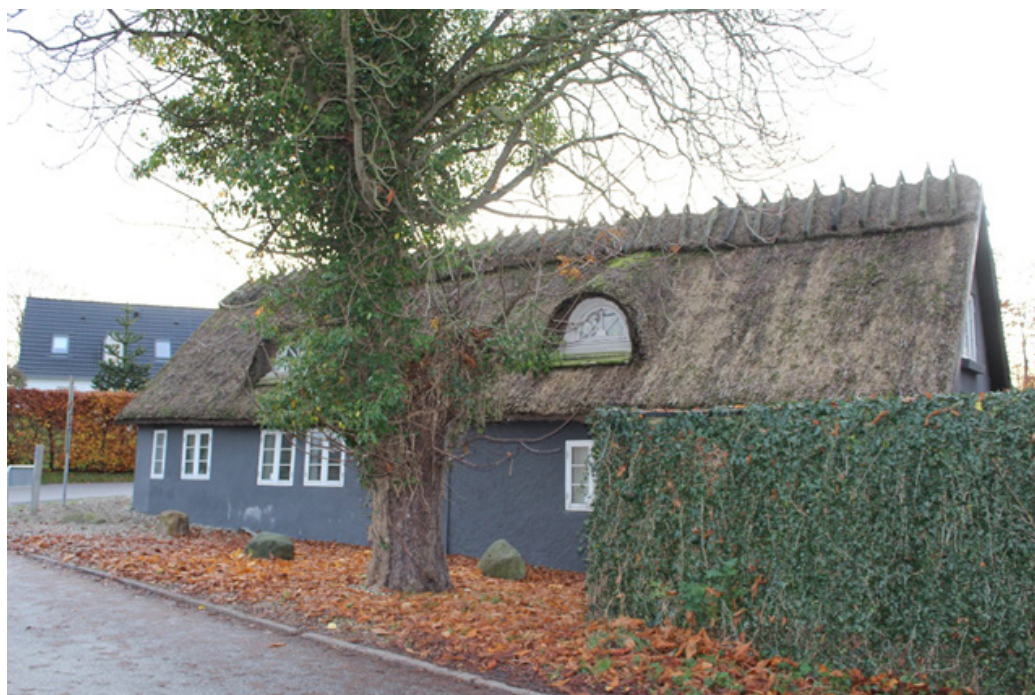
Foto: Længehusets nordvendte facade set fra Bygaden.
