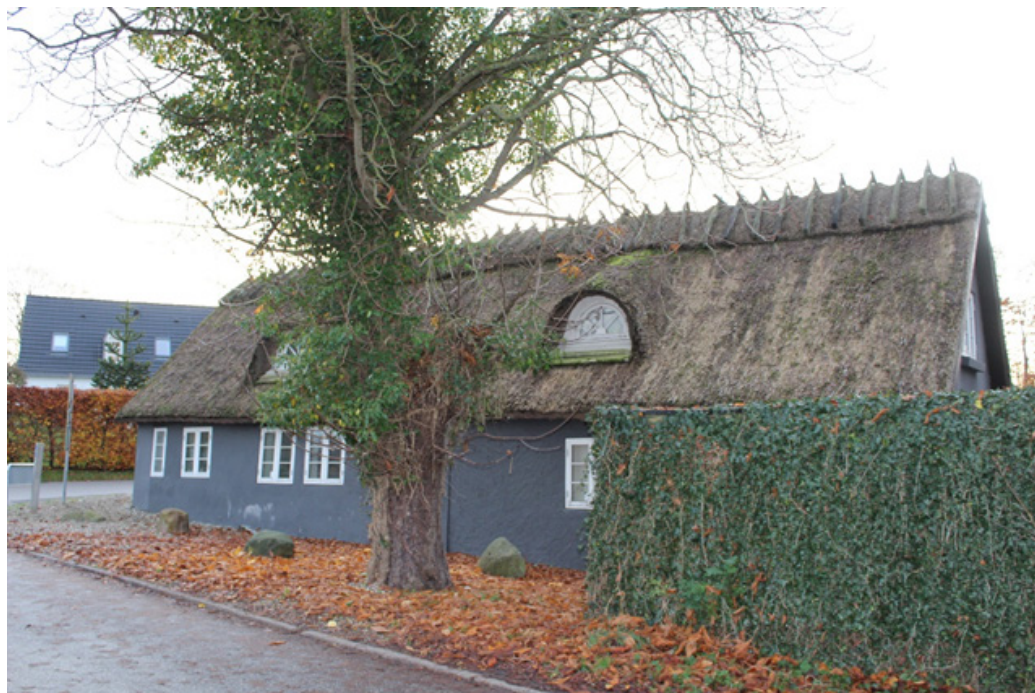
Foto: Længehusets nordvendte facade set fra Bygaden.
